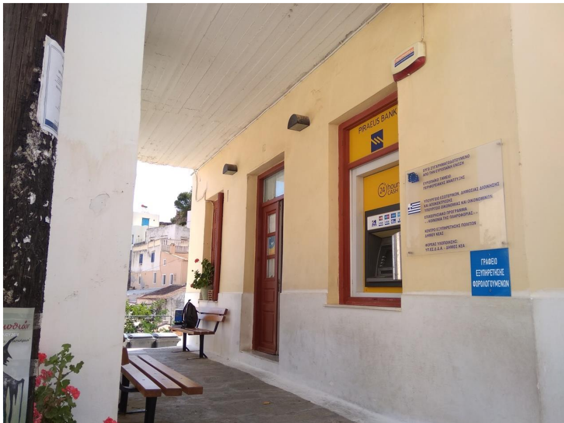
Βόρεια όψη (είσοδος ΚΕΠ)
