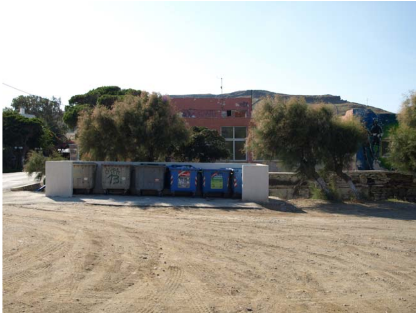
Φώτο 3.6.2 -1: Άποψη υφιστάμενου διαμορφωμένου χώρου κάδων σύμμεικτων απορριμμάτων και μπλέ κάδων
